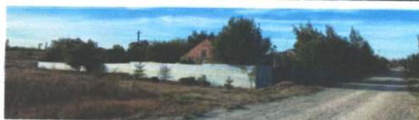
(Фотофиксация жилого здания)
